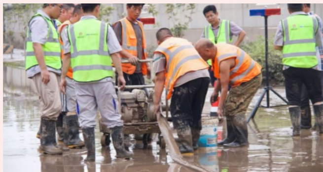
抢修抽水泵排污
