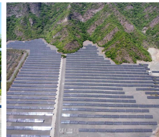
南水北调新能源宽城满族自治县地面分布式光伏项目
