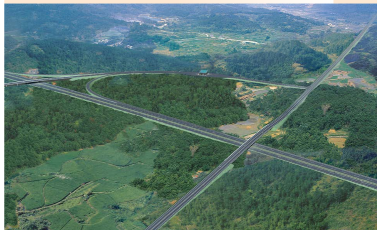
柳州高速过境线公路项目（罗城经柳城至鹿寨段）
