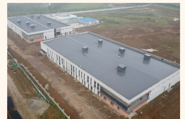
东丰县乡村振兴畜牧养殖示范基地基础设施项目
