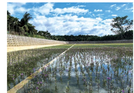
南丰溪水环境改善与水生态修复工程
