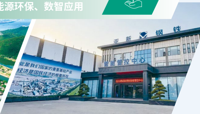
连云港亚新钢铁智能工厂项目
