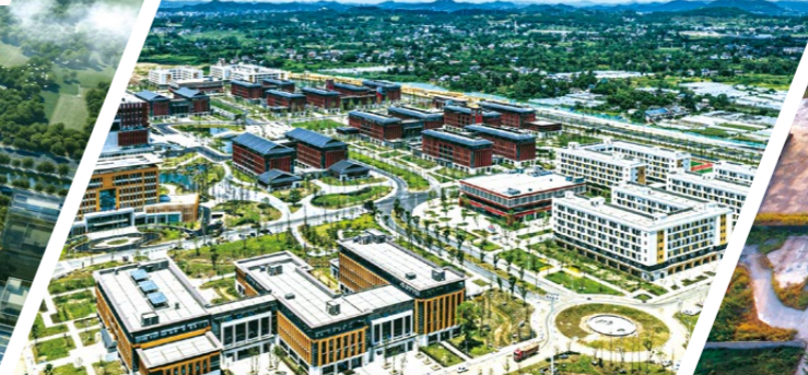
南充市医学科学产业园建设项目
