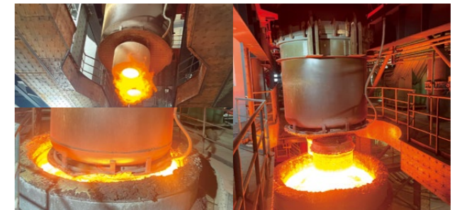
旋力特殊钢 RH 真空精炼炉总承包工程
