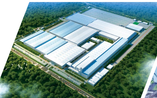
长安汽车泰国制造建设项目
