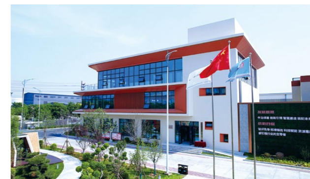
全装配式钢结构研发楼
