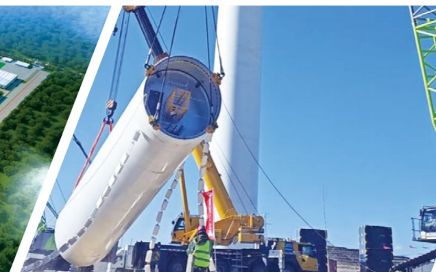
甘肃庆东数西算产业园区绿电聚合试点项目 一期工程 100 万千瓦新能源项目
