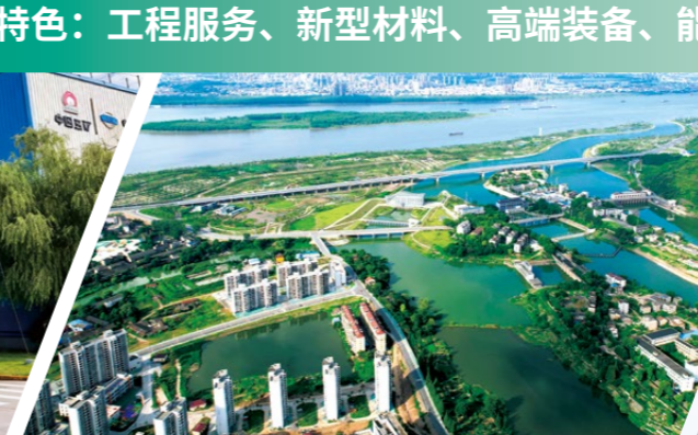
鄂州市滨江防洪生态修复项目
