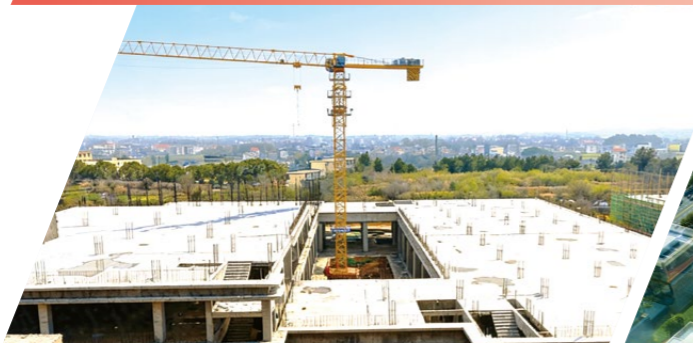
都昌县刘家山智慧科创园 EPC 总承包项目
