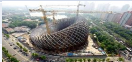
公司承建的凤凰卫视国际传媒中心项目
