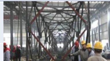
公司完成的全球第二大气田通讯铁塔制作
