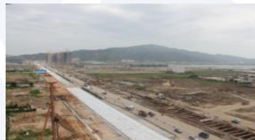
公司参建的珠海横琴岛项目
