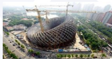
公司承建的凤凰卫视国际传媒中心项目
