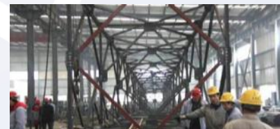
公司完成的全球第二大气田通讯铁塔制作
