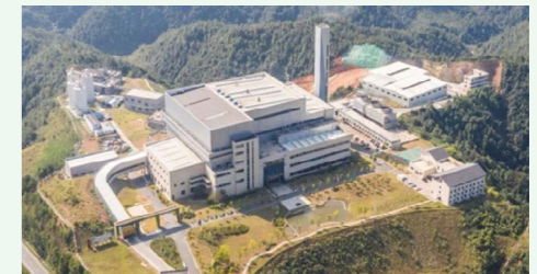
赣州市生活垃圾焚烧发电项目
