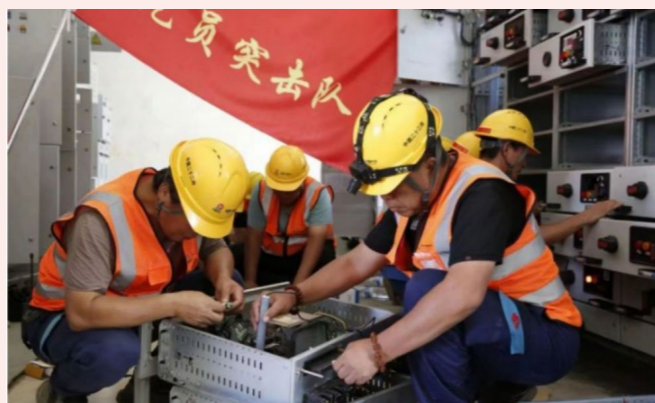
党员突击队在调试设备
