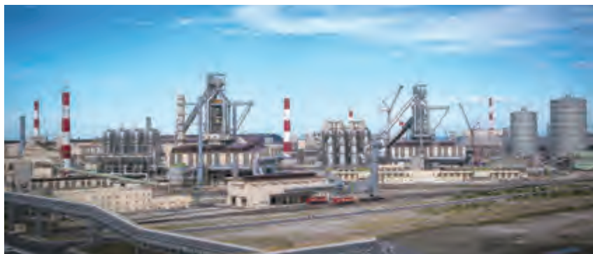
台塑河静钢铁 1 号 2 号高炉
