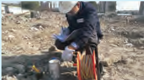
现场数据检测
