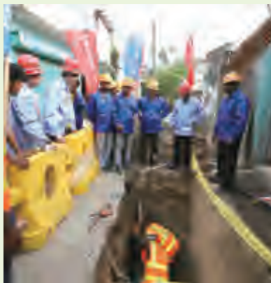
地下管网供水项目施工现场
